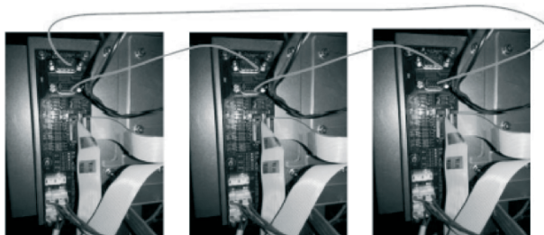
Подключение сигнального кабеля для трех ИБП, включенных в параллель
